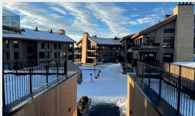
Ringsaker Vegg- og Takelementer (RVT) har levert vegglementer til leilighetsbyggene. Veggene er kledd med malmfuru.
